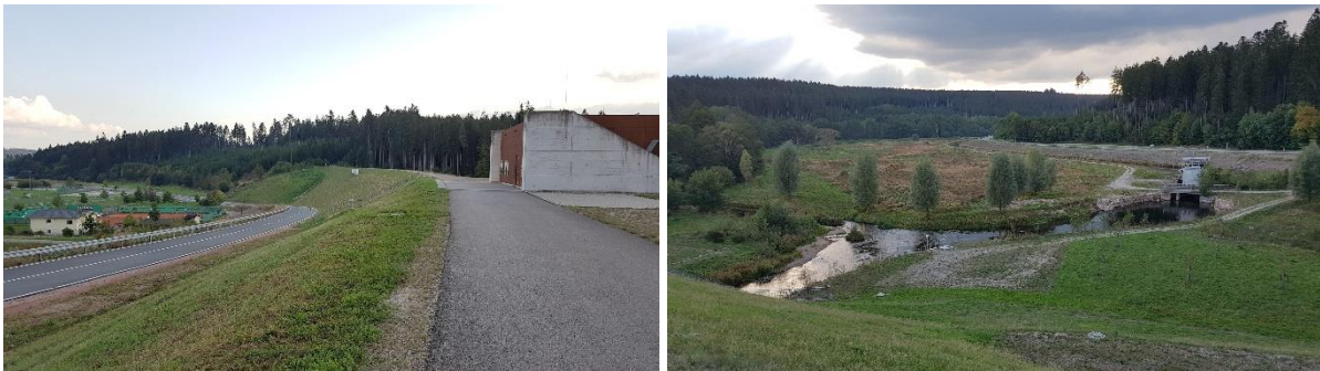
Abbildung 13 Beispiel Hochwasserrückhaltebecken Wolterdingen im Donau-Einzugsgebiet (max. Dammhöhe 18 m, Stauraum 4,7 Mio. m 3 , Bemessung auf ein 100-jährliches Hochwasser)
