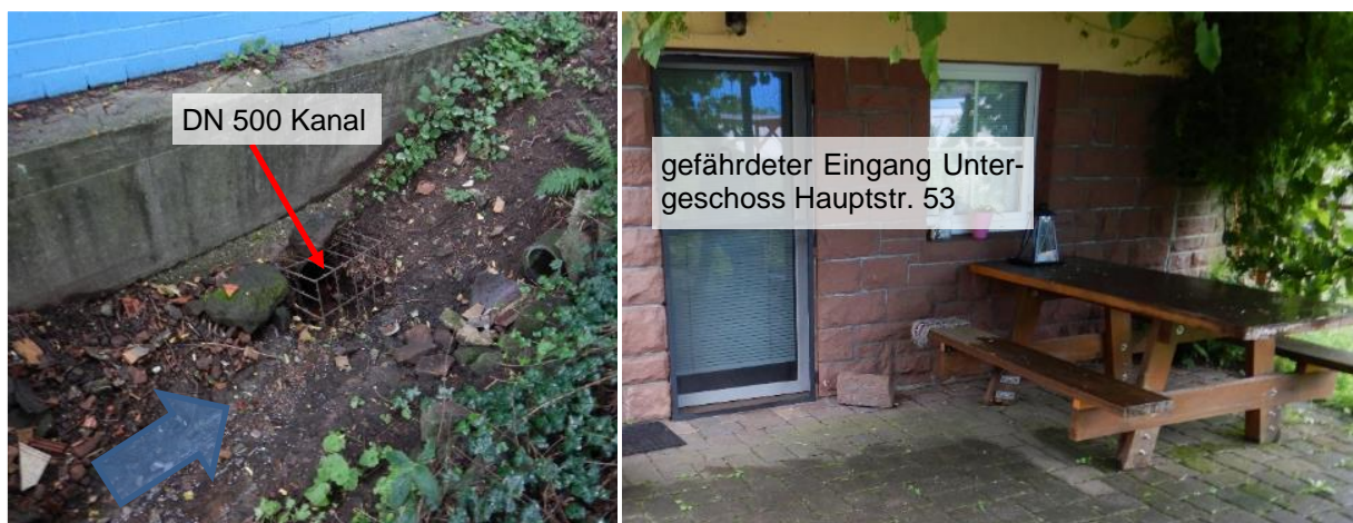
Abbildung 20 Entwässerungsgraben Industriebetrieb (links), Hauptstraße 53 (rechts)
