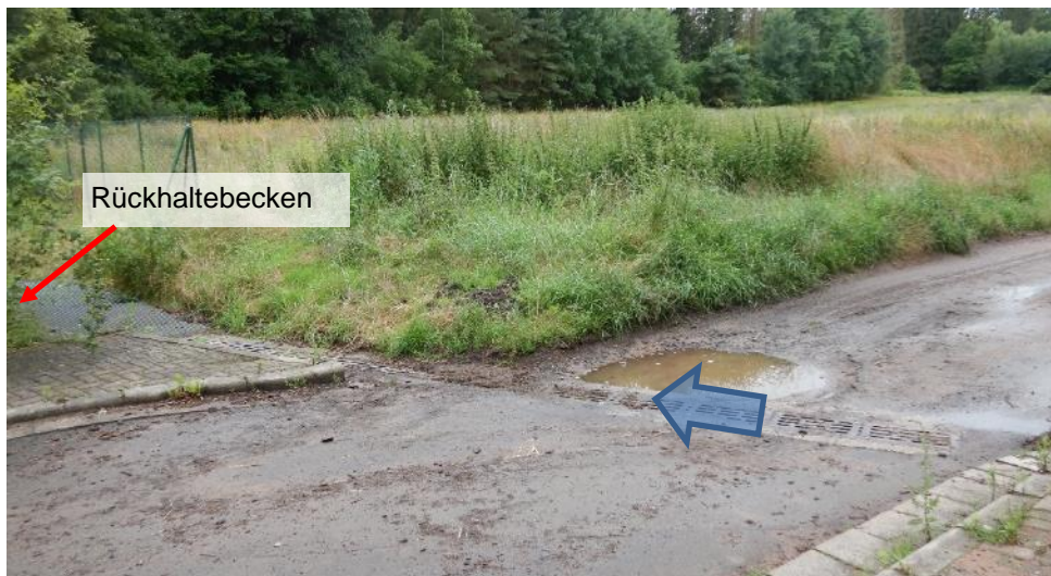
Abbildung 11 Zuleitung Rückhaltebecken im Frontal
